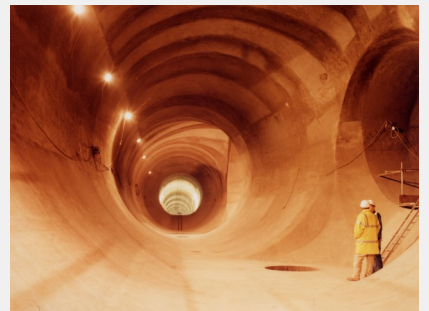
Zamontowane segmenty tunelu
